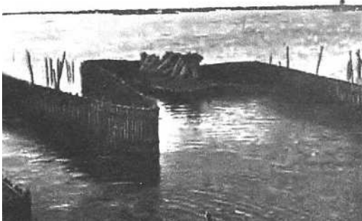
Costruzione di un lavoriero in valle semi-arginata
